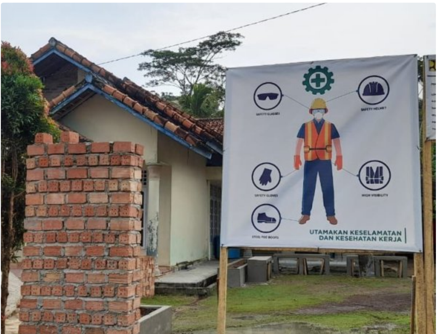
Proyek Infrastruktur Hunian Hijau di Mesuji
